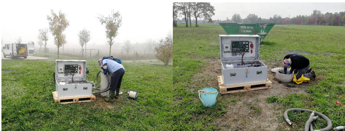
Slika 14 Vgradnja opreme za izvedbo poizkusov (levo FS, desno FFA)
